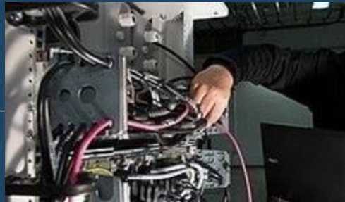
Mises en service sur sites
